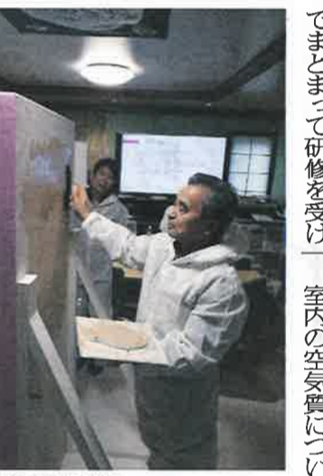
▲施工研修の様子
